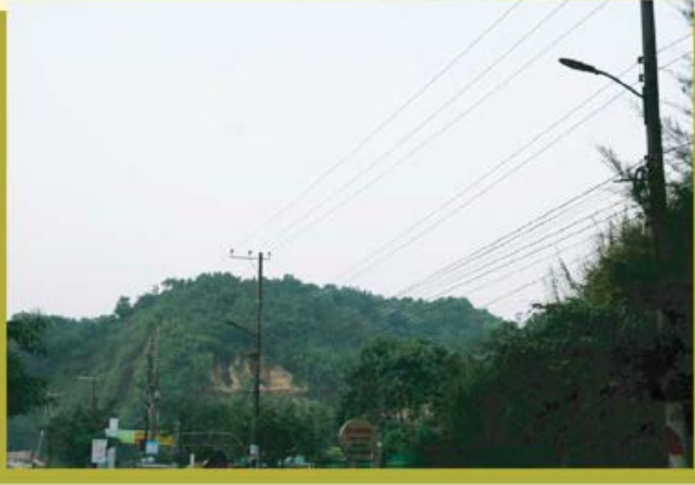
কক্সবাজার উন্নয়ন কর্তৃপক্ষের সড়ক আলোকায়ন-০১ প্রকল্পের আওতায় মেরিন ড্রাইভ সড়কের দরিয়ানগর হতে হিমছড়ি পর্যন্ত এলইডি লাইট স্থাপন করা হয়েছে
